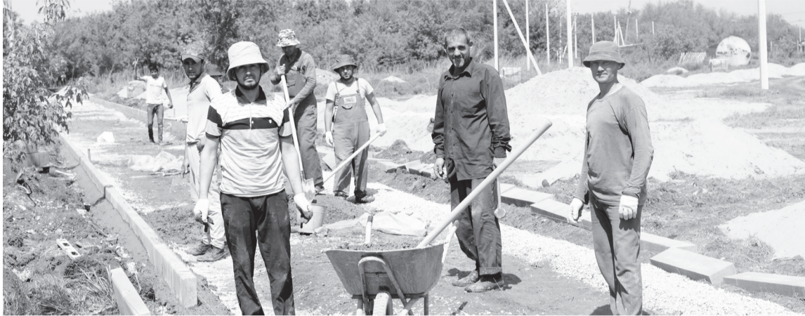
В селе Красноармейское, на ул. Полевой, началось строительство набережной
