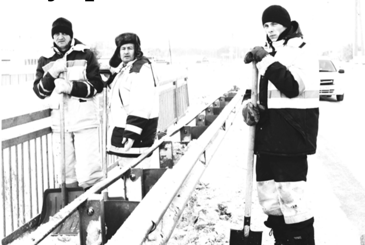
Бригада дорожных рабочих в момент очистки светобарьерного ограждения от снега
