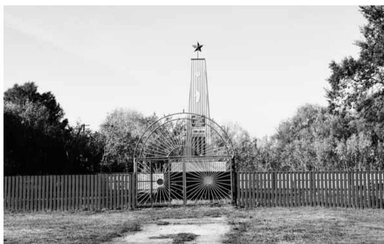
После проведённой реконструкции в посёлке обновился парк
