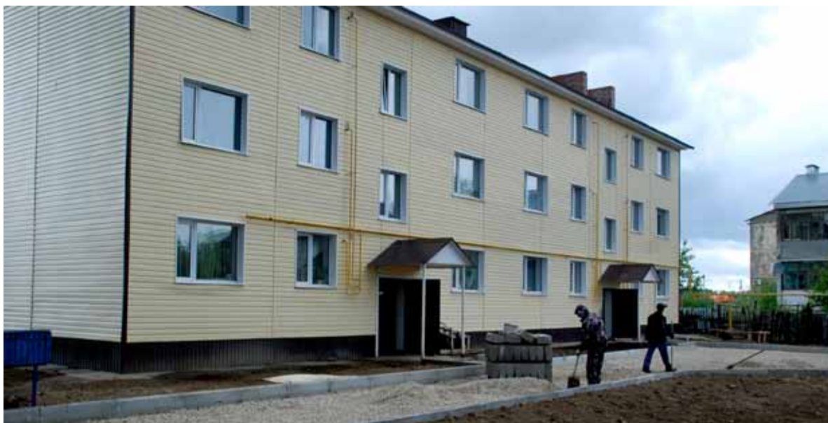
Строительство нового жилья в с. Красноармейское.
