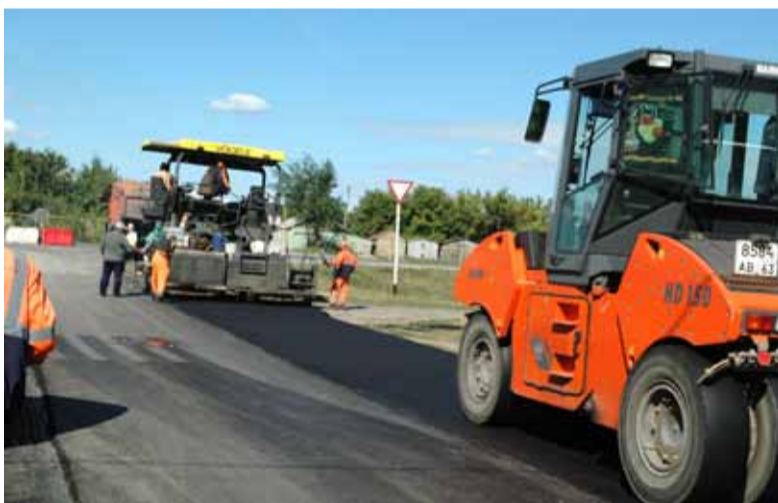
Капитальный ремонт дороги в районном центре.
